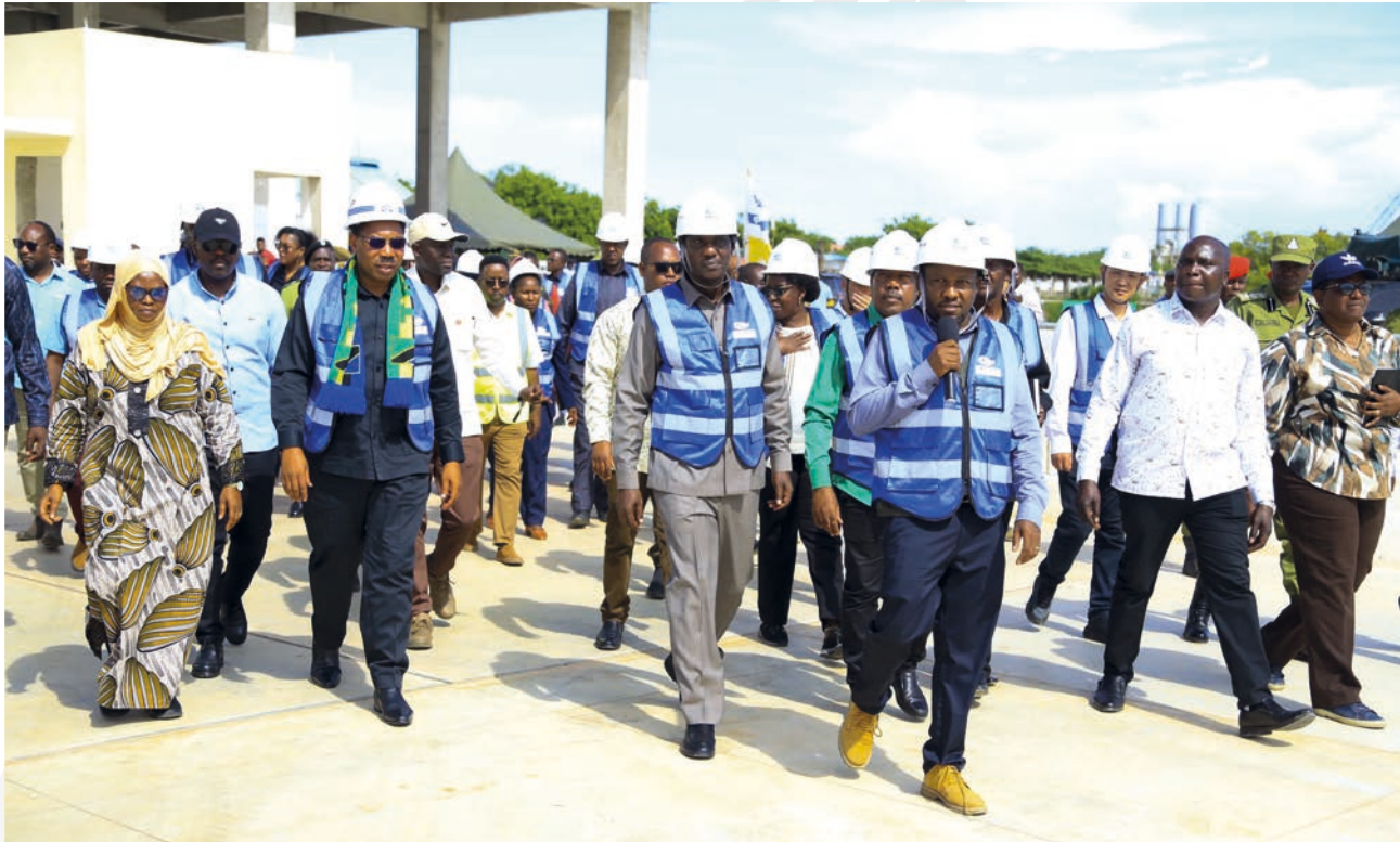
Waziri Mkuu wa Jamhuri ya Muungano wa Tanzania Mhe. Dkt. Mwigulu Nchemba (wa tatu kutoka kushoto) akikagua hatua mbalimbali za ujenzi wa bandari ya Uvuvi iliyopo Kilwa mkoani Lindi Desemba 19,2025. Kushoto kwake ni Waziri wa Mifugo na Uvuvi Mhe. Balozi Dkt. Bashiru Ally Kakurwa.
